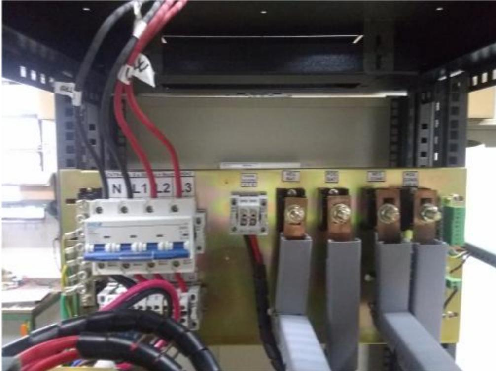
Fig. 3.-Borneras de conexión señales
